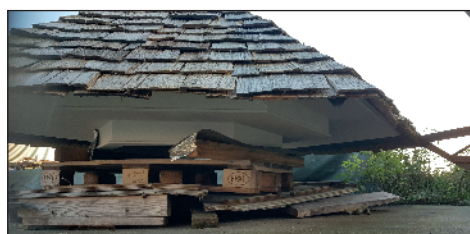
Zwaluwtil in aanbouw (1).
