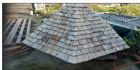
Zwaluwtil in aanbouw (2).
